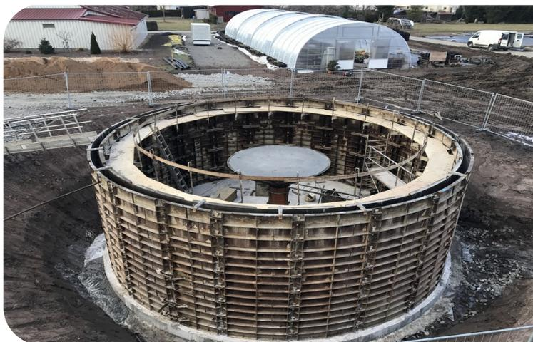
Die monolithischen Betonbehälter werden meist unterirdisch mit Decke erstellt, d.h. nicht sichtbar und ohne Flächenverlust.
