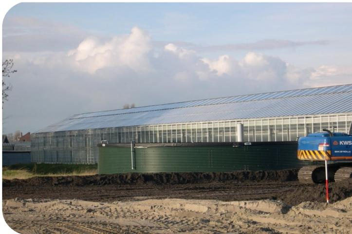
Die Stahltanks lassen sich in 1-3 Tagen montieren und sind versetzbar. Wir liefern die Stahltanks mit einer zugelassenen Statik und auf Wunsch mit der notwendigen Eingabeplanung.
